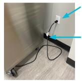
WALL OUTLET **MINIMUM** 20 AMP CIRCUIT **REQUIRED**
